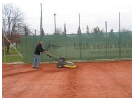
1-Odstranitev odvečnega op. zdroba
